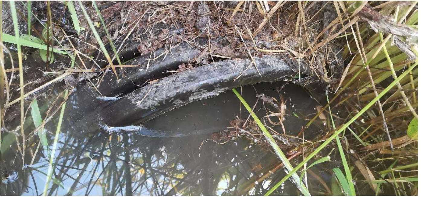
Foto 4. Vaade truubi sissevoolule, 12.09.2024. Truubis ja teekraavides seisev vesi.
