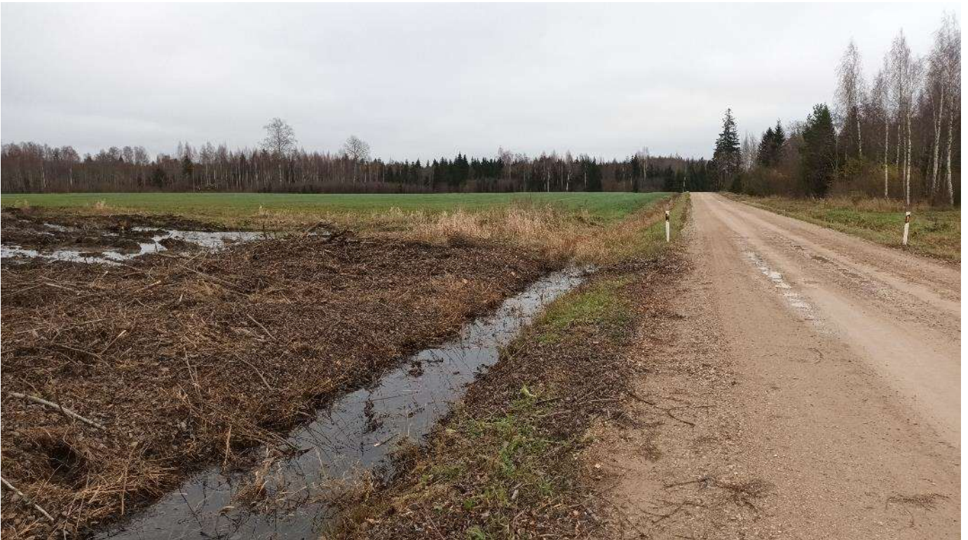
Foto 5. Teekraav T-5, 06.11.2024. Helkurpostide juures teetruup. Truubis ja teekraavides seisev vesi.
